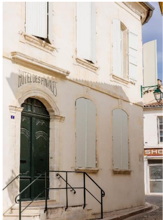
1 Rampe des Mobiles Hôtel des Finances Opération façade effectuée en 2019
