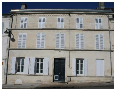
Exemples d'opération façades
