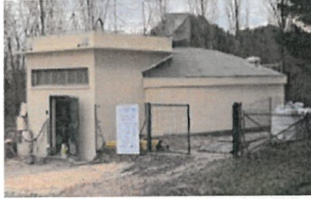
Réservoir d'Aubeterre - Commune d'Aubeterre-sur-Dronne -
